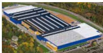
Hörmann KG Eckelhausen, Allemagne
