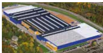
Hörmann KG Eckelhausen, Allemagne
